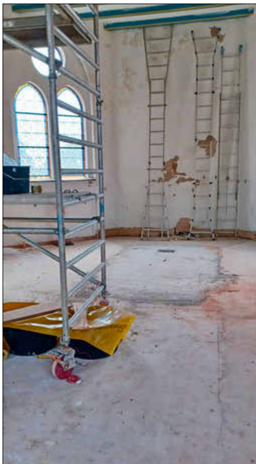
Fliesen entfernt, Schacht des ehemaligen Sargaufzugs geschlossen, aber noch zu erkennen.
