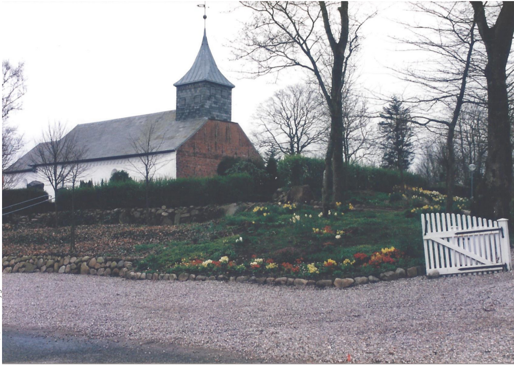
Kirche und Friedhof in Uberg/Ubberg wurden auf einer Warft gebaut, damit die Hochwasser im Winter ihnen nichts anhaben können.
